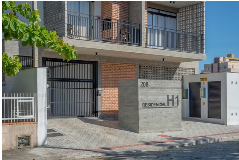
Figura 20 – Edifício H1 – Elementos da fachada
