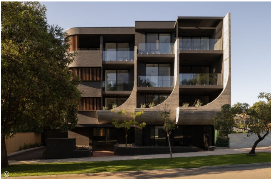
Figura 4 – Edifício Evans Street – Fachada principal
