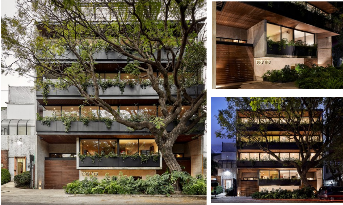
Figura 11 – Edifício PRV 843 – Fachada Principal
