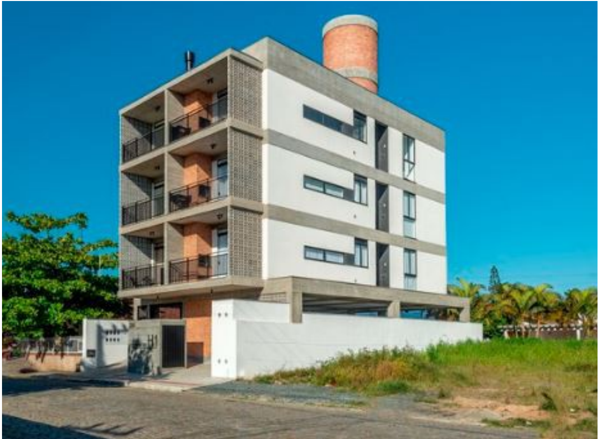
Figura 18 – Edifício H1 – Fachada em perspectiva
