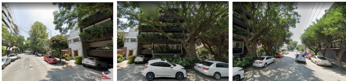
Figura 15 – Edifício PRV 843 – vistas da rua
