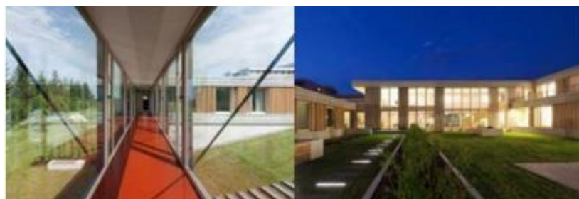
Figura 14 – CENTRO DE REABILITAÇÃO FRIEDRICHSHAFEN, ALEMANHA
