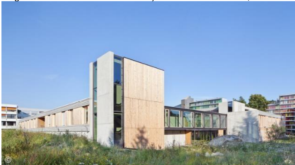
Figura 16 – CENTRO DE REABILITAÇÃO FRIEDRICHSHAFEN, ALEMANHA
