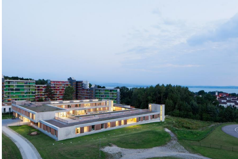
Figura 12 – CENTRO DE REABILITAÇÃO FRIEDRICHSHAFEN, ALEMANHA
