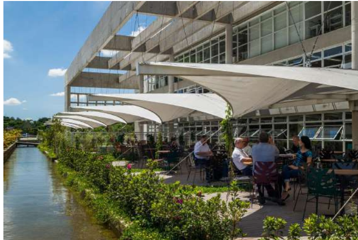
Figura 24 - Fachada de Concreto
