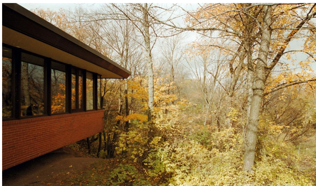
Figura 17 – Balanço da Sala da Casa Keland
