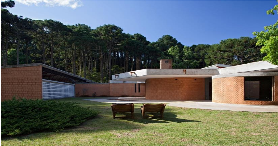
Figura 20 - Área Externa da Residência Sapucaí-Mirim
