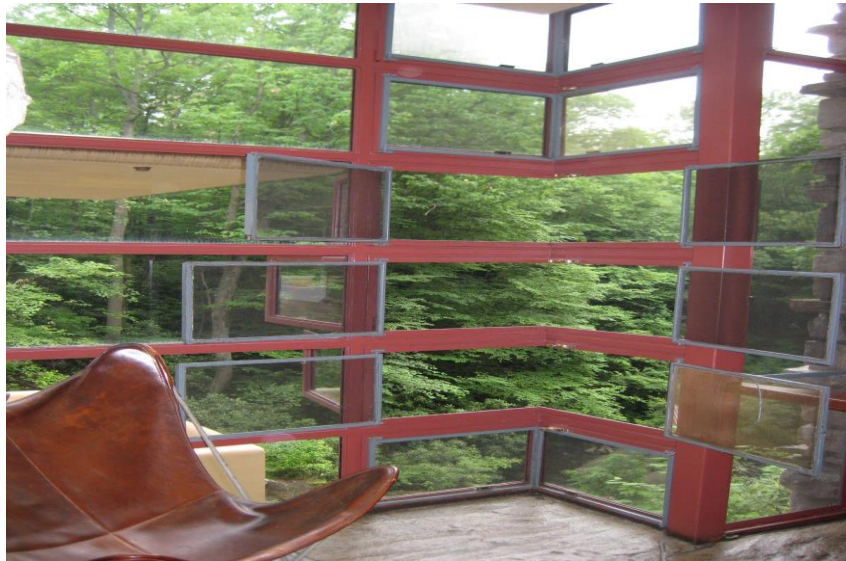
Figura 8 - Janela com Abertura na Esquina da Casa
