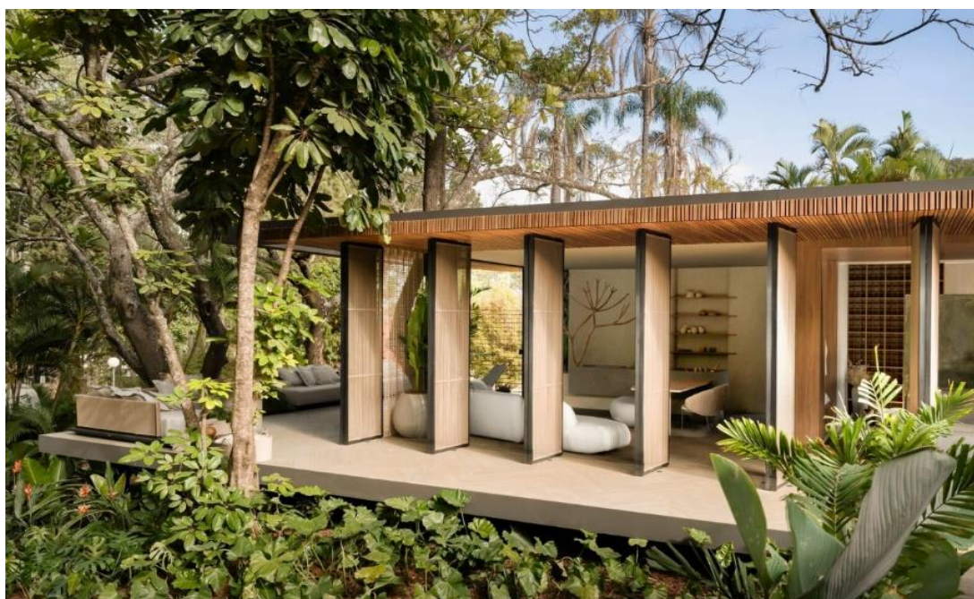
Figura 28 – Varanda da Casa Sui
