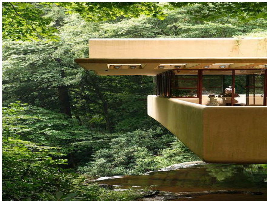
Figura 7 - Varanda em Balanço
