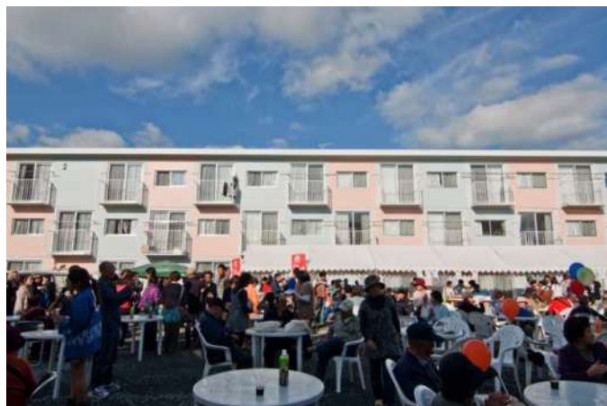
Figura 18 - Fachada habitação temporária
