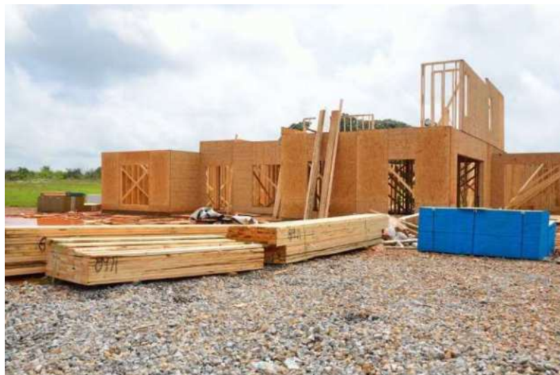
Figura 7 - Montagem em Woodframe
