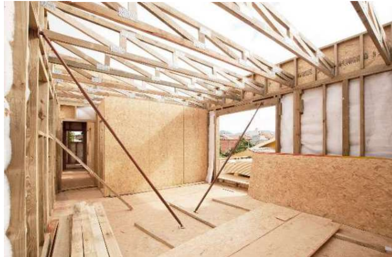
Figura 6 - Construção em Woodframe
