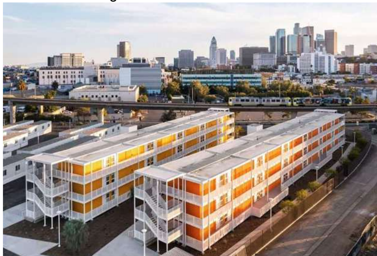
Figura 21 - Vista I do condomínio
