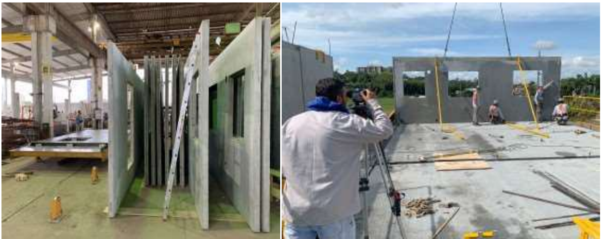
Figura 5 - Painéis pré-fabricados e montagem
