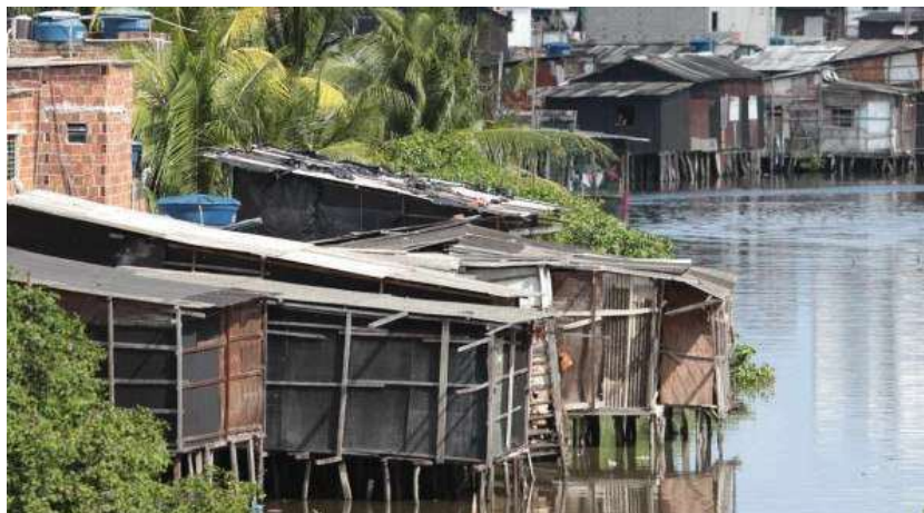
Figura 3 - Palafitas no bairro do Pina, Recife
