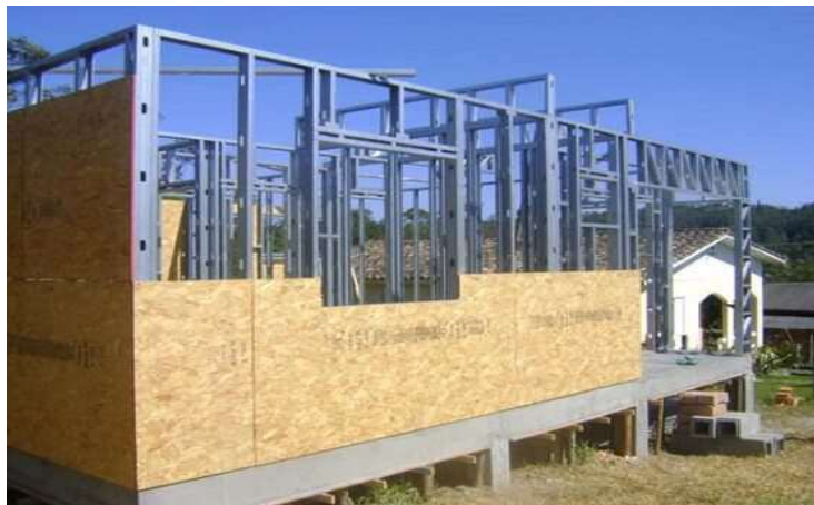
Figura 9 - Preenchimento com painéis e placas
