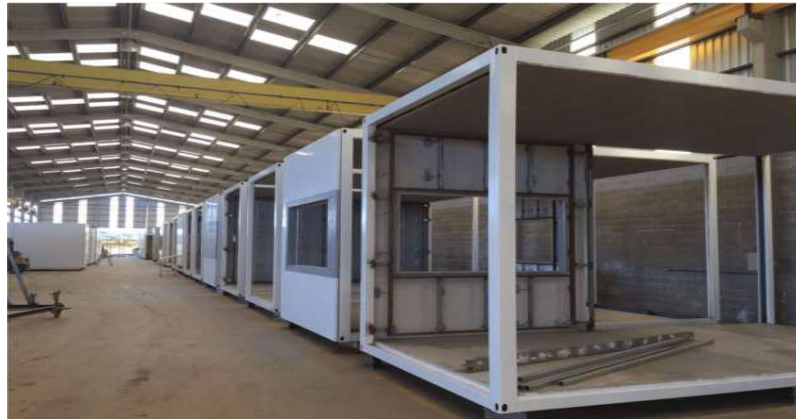
Figura 4 - Estruturas em aço - Pré-fabricação
