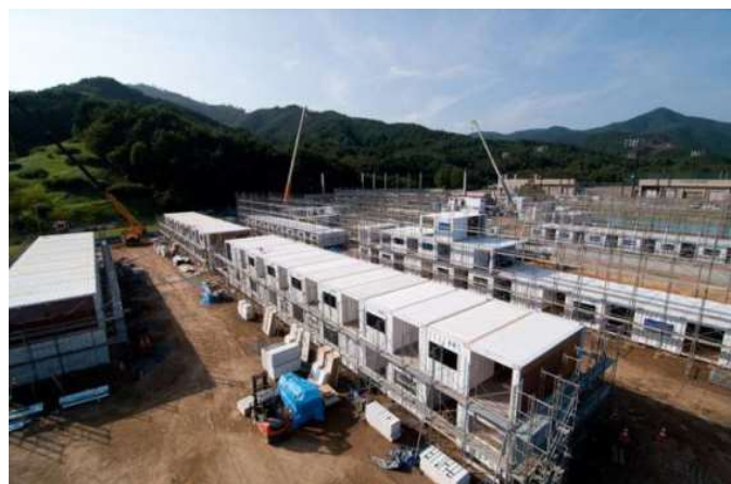
Figura 16 - Fase de construção
