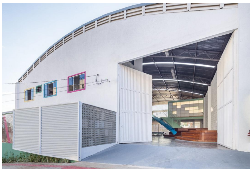
IMAGEM 15: ESCOLA CASA FUNDAMENTAL – USO DA ESTRUTURA DO GALPÃO JÁ EXISTENTE
