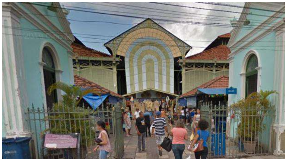
Figura 18: fachada principal do mercado
