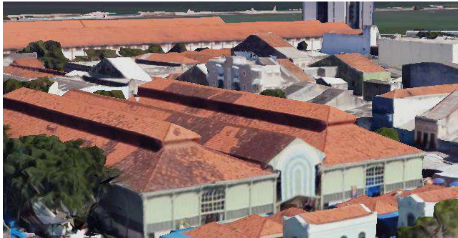
Figura 16: Detalhe das telhas de barro
