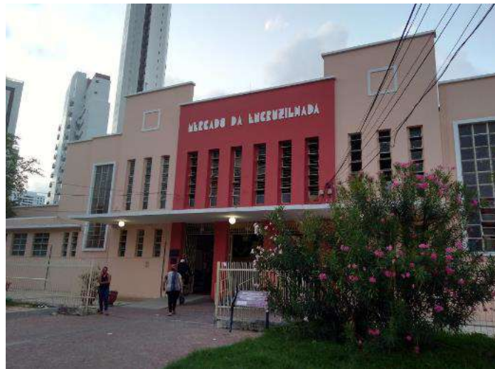
Figura 25: Fachada principal do mercado.
