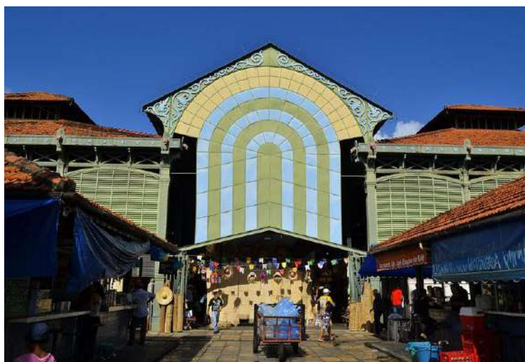
Figura 15: Detalhes dos arcos e colunas.
