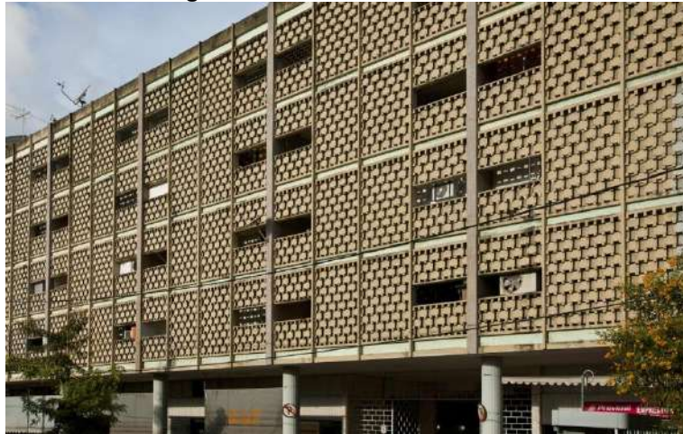
Figura 30 - Edifício Santo Antônio
