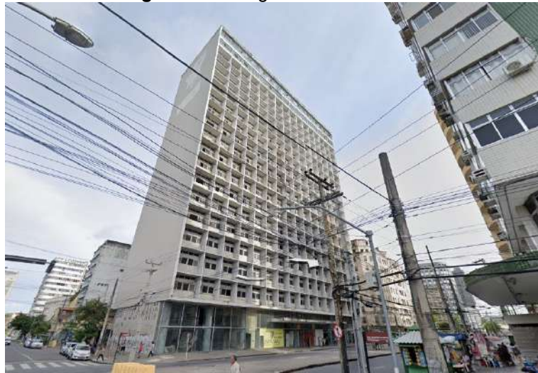
Figura 32 - Antigo Edifício do INSS
