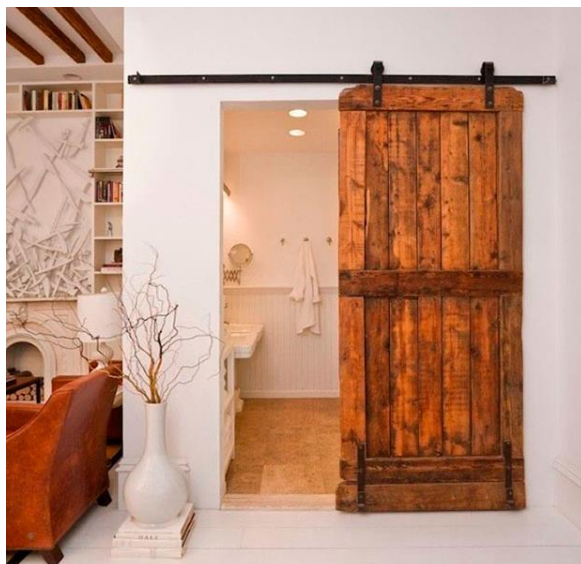
Figura 24: Porta de Madeira de Demolição
