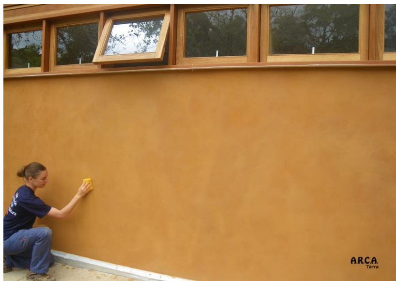
Figura 10: Revestimento externo terra/cal
