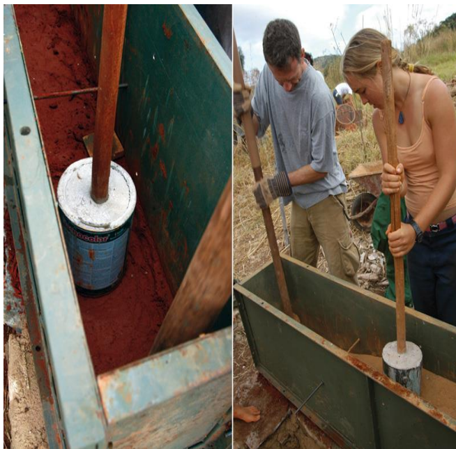
Figura 19: Compactação da terra na forma
