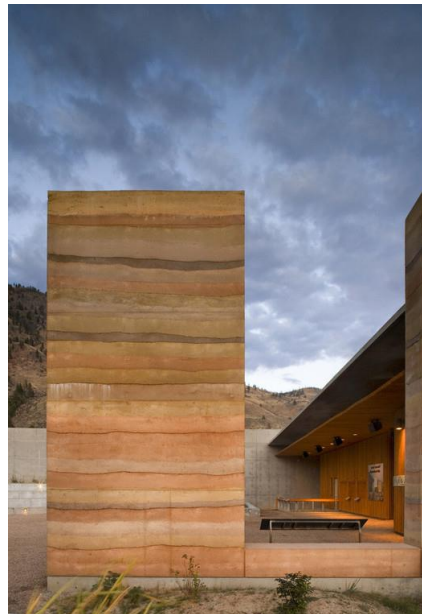
Figura 06: Parede erguida após retirada das formas
