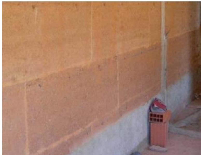
Figura 11: Reconstrução de parede de terra compactada com subida do lintel de fundação
