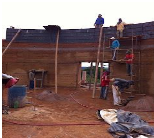
Figura 20: Retirada das formas
