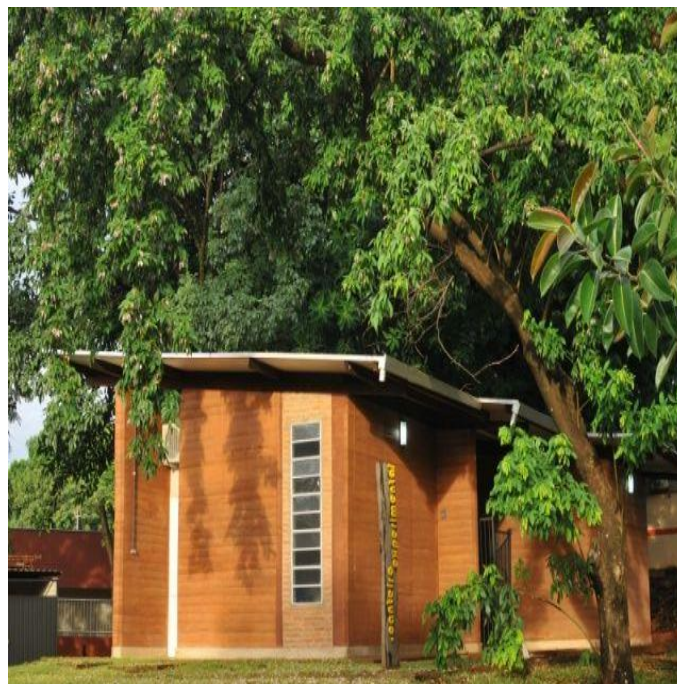
Figura 15: Casa de terra compactada, canteiro experimental UFMS
