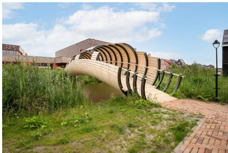
Figura 21. Passarela sobre o rio.
