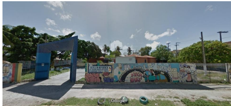
Figura 3 – Vista da Fachada, Rua Paraná.
