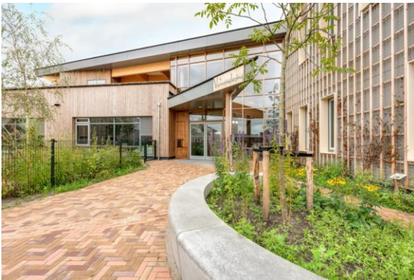
Figura 16 – Vista externa da escola e fachada.
