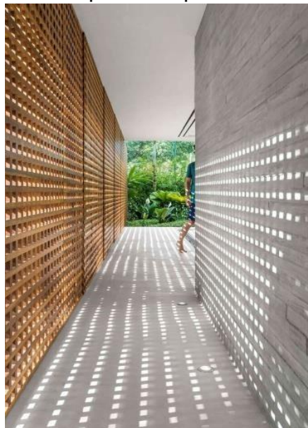
Imagem 2- Corredor com paredes que facilitam a entrada de ar.
