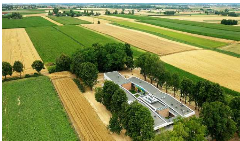
Figura 9: Vista superior da edificação
